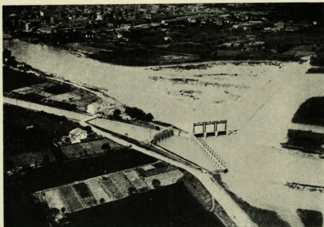
La resclosa del Canal de Serós, que desvia les aigües del Segre i les condueix fins a la Central d'Altona.
