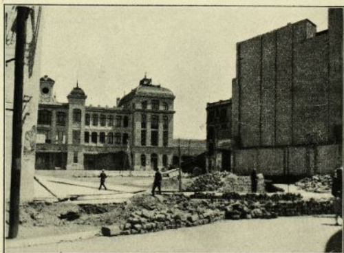
Estat de les obres de la nova plaça del Príncep, que esdevindrà una bella entrada a la nova estació.
