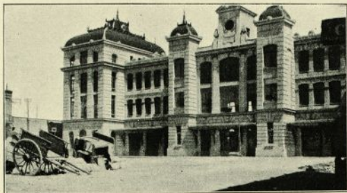
L'edifici de la nova estació de ferrocarril, se'n presenta aquí ja quasi acabada
