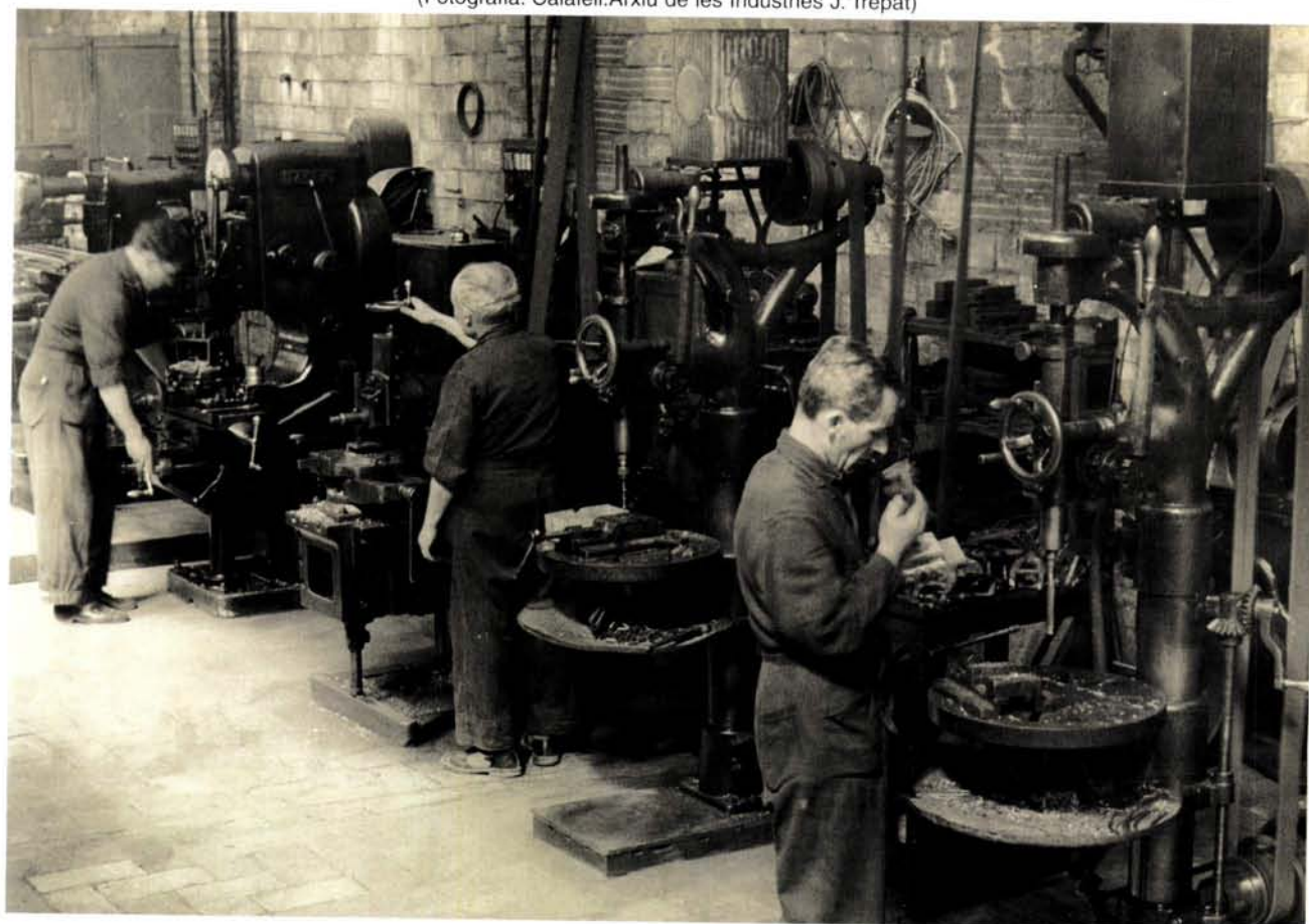
Nau número 10. Treballadors de la Secció d'Estampació fent funcionar les màquines de foradar. Anys 1961-62. (Fotografia: Calafell.Arxiu de les Indústries J. Trepai)
