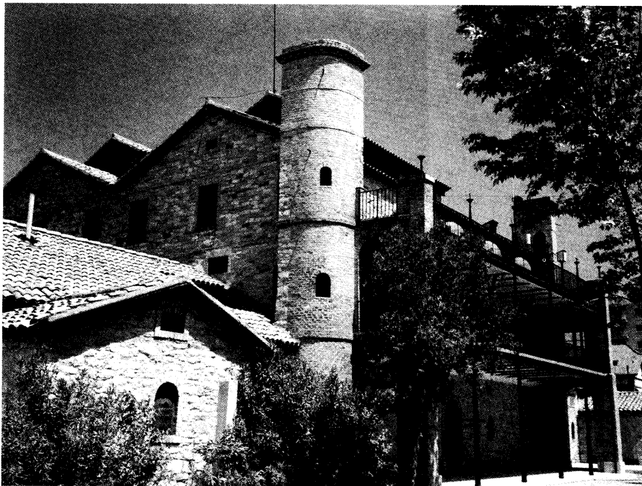
Façana de la Comunitat General de Regants del Canal d'Urgell.
